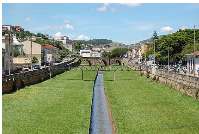
Figura 02: Córrego do Lenheiro depois da canalização Fonte: Leonardo Soares Ferreira
